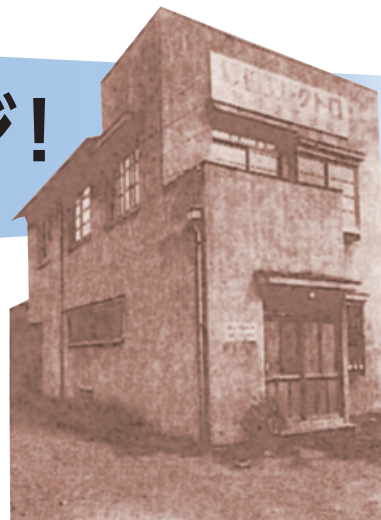
福田エレクトロ製作(株)の外観
